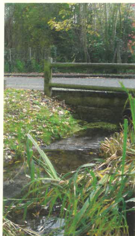
Passage de l'eau de la source sous la route
